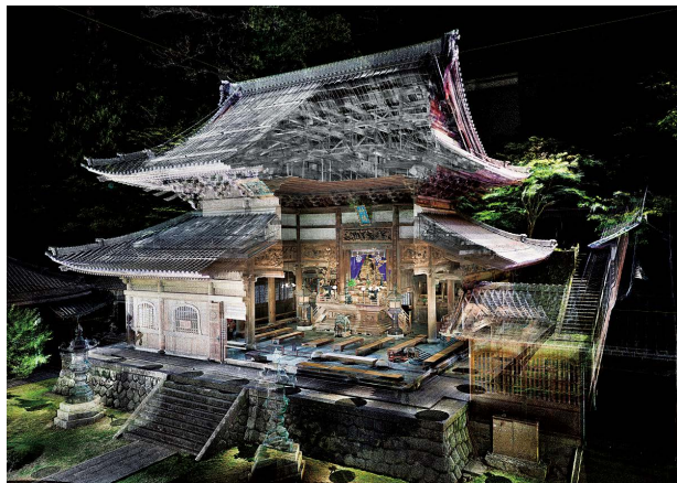
仏殿の点群データ（外観と内部を同時に表示） [永平寺・清水建設共同調査 測量協力T&I 3D]
