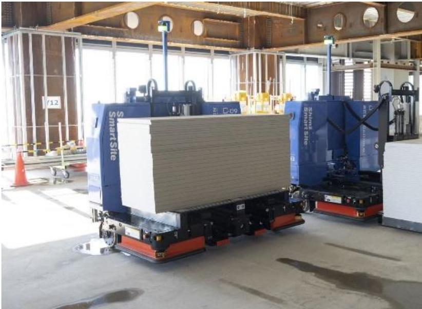
資材の搬送効率を向上させる「Robo-Carrier」
