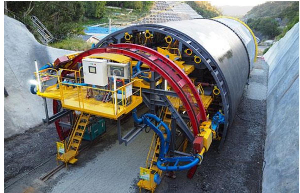
マニピュレータ式の自動打込み装置
