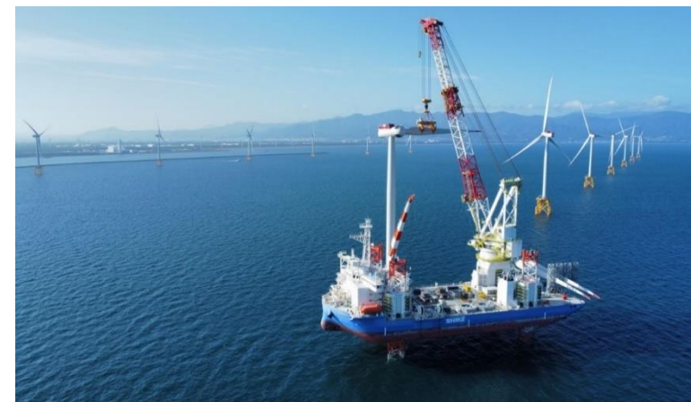
石狩湾洋上風力発電所 当社保有の自航式SEP船「BLUE WIND」で施工済
