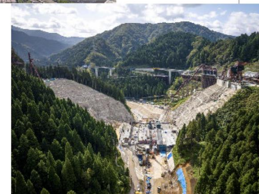
足羽川ダム（福井県）
