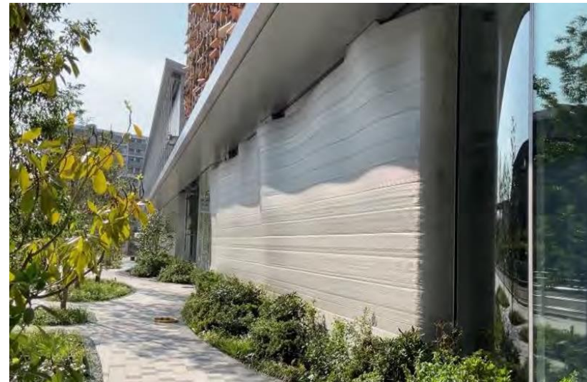
在来工法では難しかった自由曲面形状の造形も容易に実現
