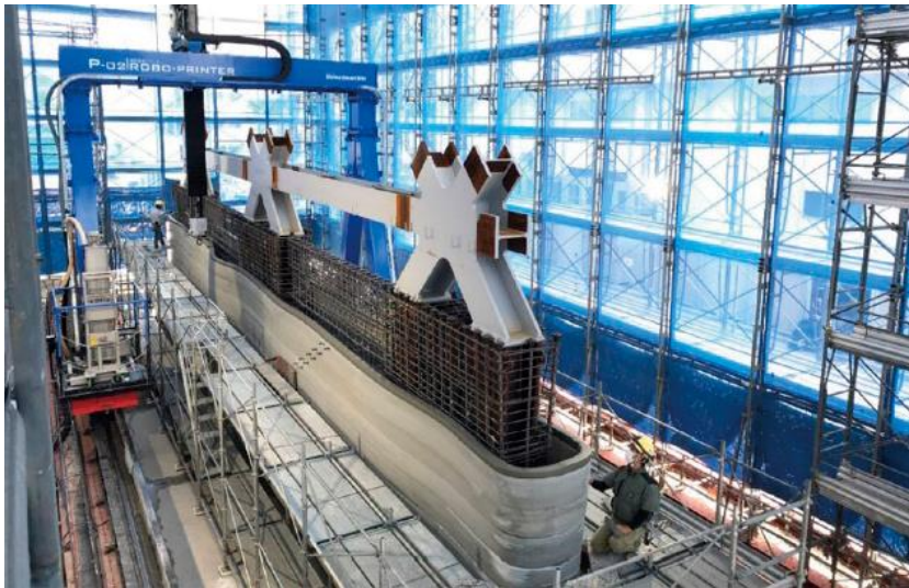
オンサイト3Dプリンティングの施工状況
