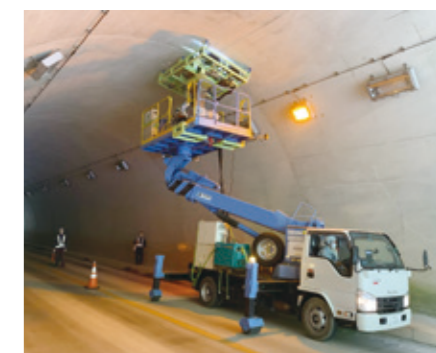
トンネル全断面点検・診断システムiTOREL
