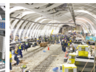
実際の施工状況
