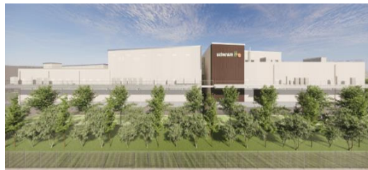
(株)マルエツ草加デリカセンター新築工事 埼玉県草加市
