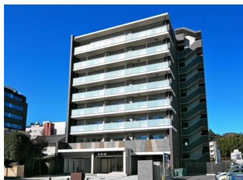
丸伊呉服店ビル新築工事
