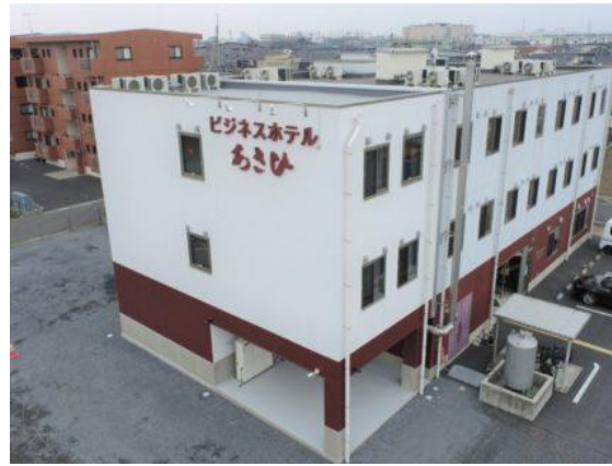
ホテル増築工事
