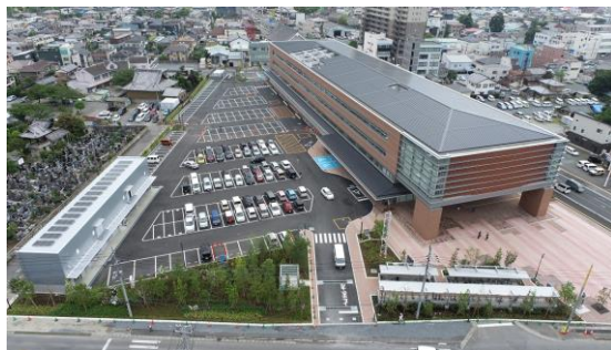
深谷市役所建設工事
