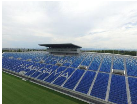
スタジアム外部改修工事
