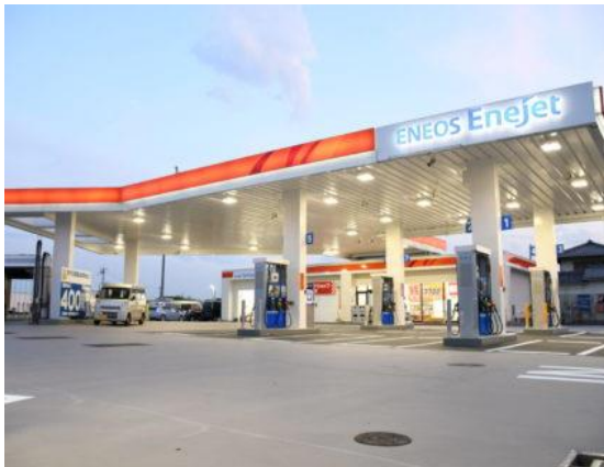
ガソリンスタンド再生改造工事
