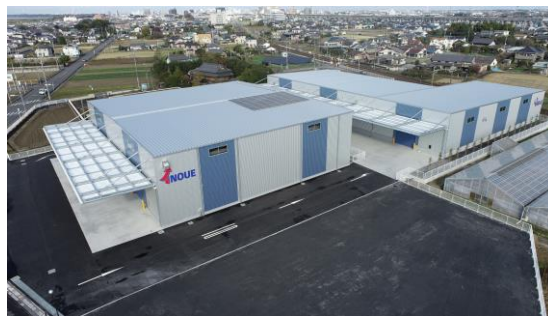
物流倉庫建設工事
