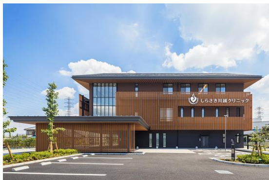
クリニック建設工事
