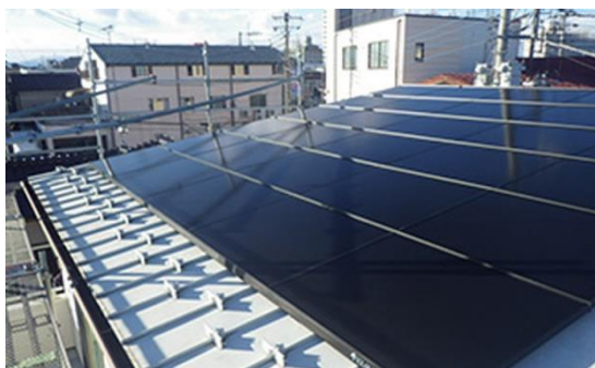
住宅屋根への太陽光設置
