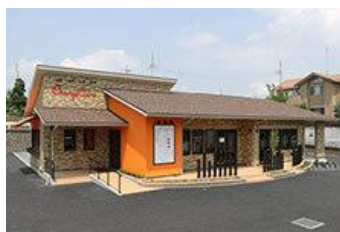
商業施設建築工事
