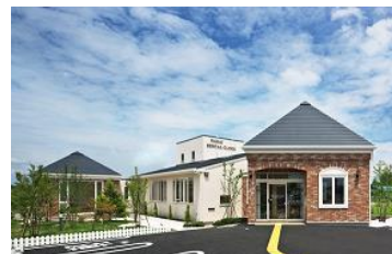
クリニック建築工事
