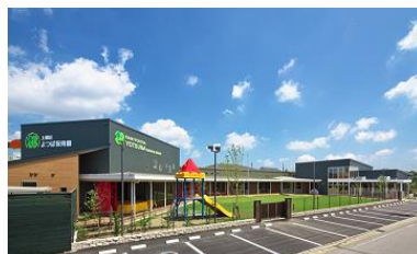
保育園建築工事
