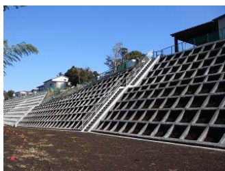
斜面对策工事
