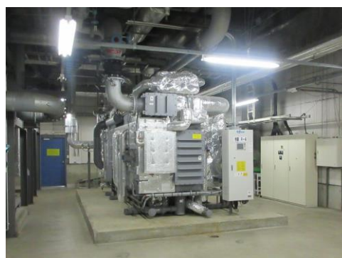
施設内に設置されるガスコージェネレーションシステム
