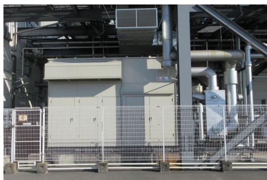
施設内に設置されるガスコージェネレーションシステム
