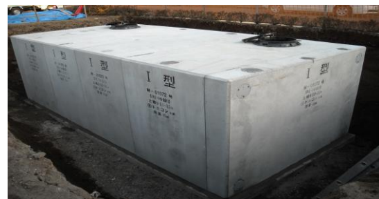
耐震性貯水槽
