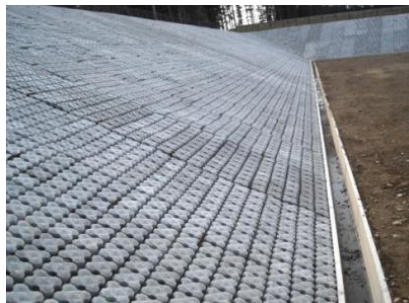
護岸ブロック
