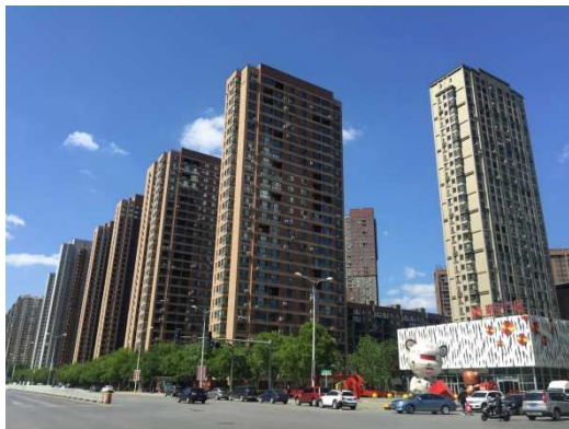
中国・瀋陽市 瀋陽明天広場PJ 一部竣工写真
