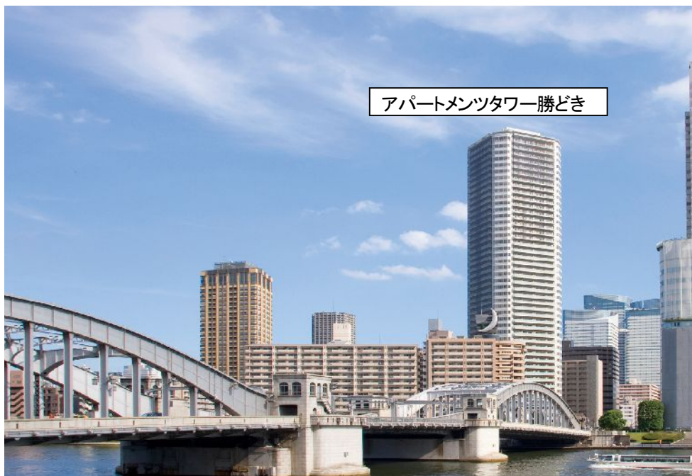
施工中写真（平成22年9月撮影）
