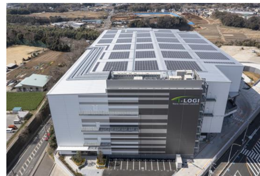
▲ T-LOGI千葉北 (2023年2月竣工)
