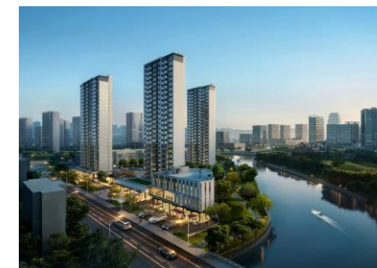
▲ 温州甌海PJ (2024年竣工)
