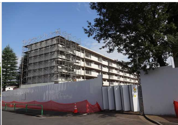
既存建物の解体準備の様子(2020年10月時点)
