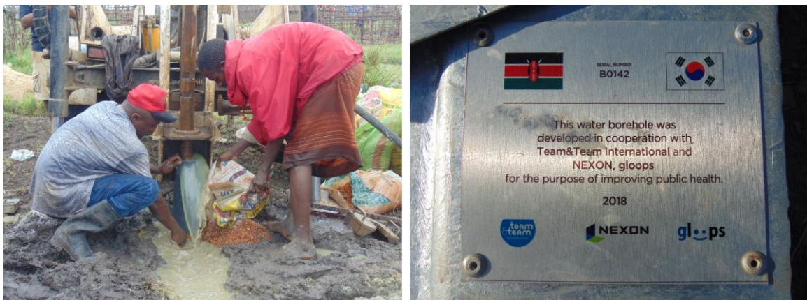
(左: 井戸を建設するサミカ村の人びと 右: 井戸完成を記念したネームプレート)
