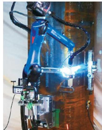
溶接中のRobo-Welder（鉄骨柱溶接ロボット）
